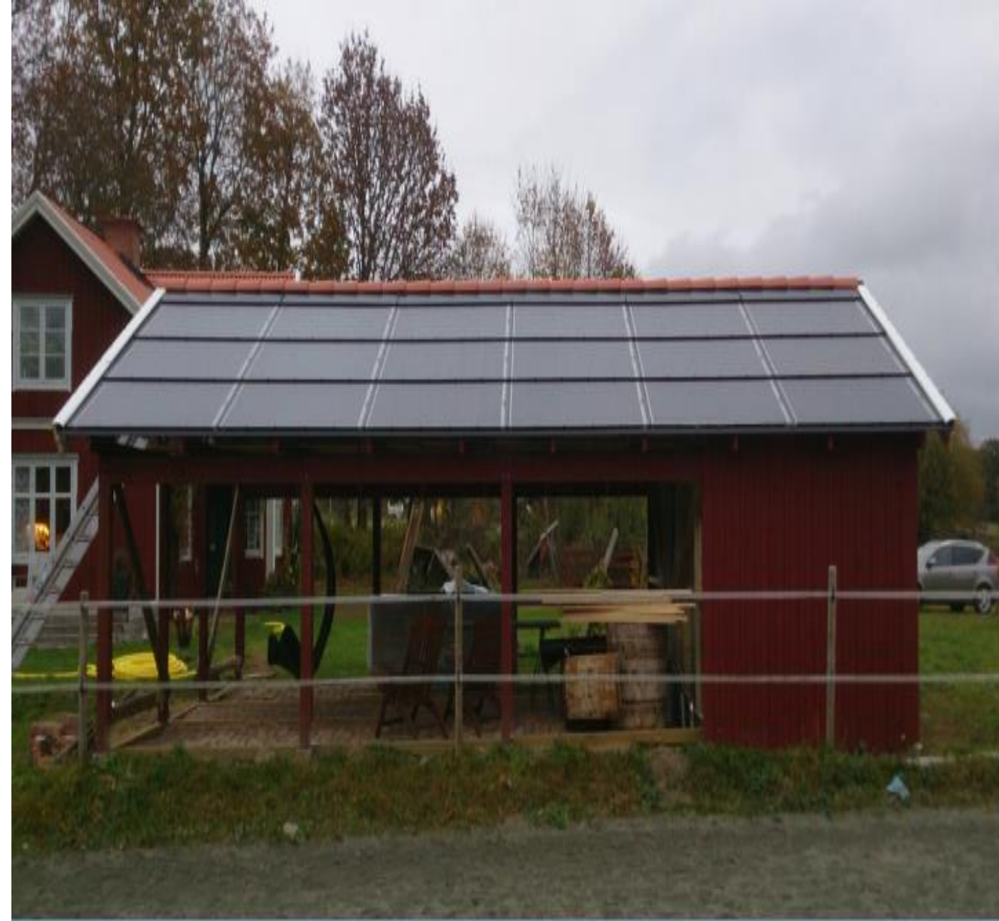
Solrif® carport, 4,5 kW, Sweden
